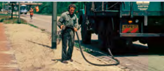
1. Arbeitsgang. Auf den aufgebrachtten Sand wird am 12. Juni 1985 eine Mischung aus Grünkompost inklusive der eigentlichen Wildblumensamen angespritzt.
