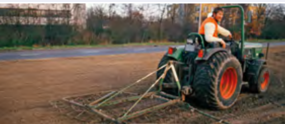
EGGEN ALS SAATBEETVORBEREITUNG. Bei allen Ansaaten ab 1990 wurde die aufgeschüttete Sandfläche vor der Hydrosaat geeget. Danach kam die Anspritzbegrünung in zwei Schritten wie schon zuvor. Diesmal zusätzlich mit Zellulose als Kleber, um das Saatgut auf den erosionsanfälligen Sanden zu halten.
